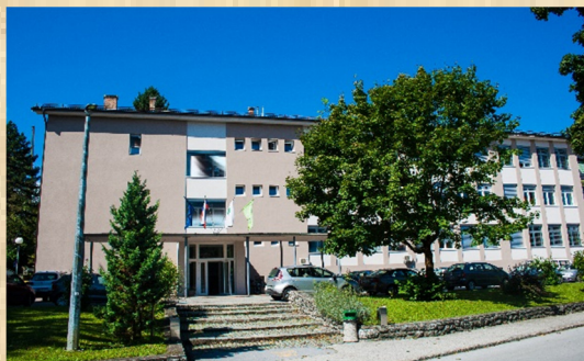
- vajenska šola na Ulici talcev 3
