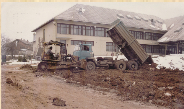
Gradnja športne dvorane pri šolskem objektu na Ulici Milke Šobar 30
